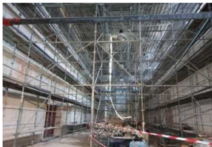
Une forêt d'échafaudages a poussé dans la chapelle du couvent. FABIEN JANS
